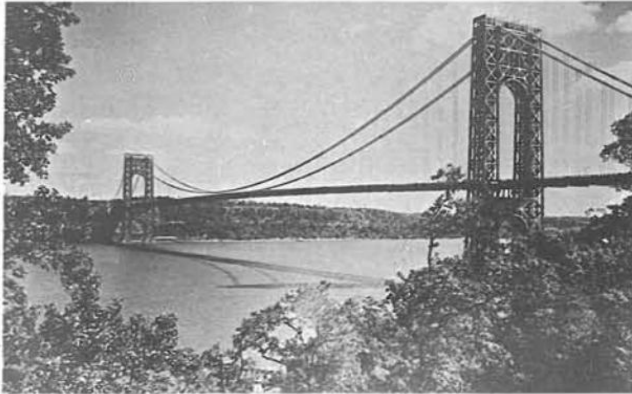
Puente de George Washington (Ammann, 1931) L = 1.060 m. Este puente, previsto para dos tableros superpuestos, no pudo ser construido más que con el superior a causa de los problemas económicos producidos durante la depresión. El segundo tablero junto con la viga de rigidez se construyó en 1950.
