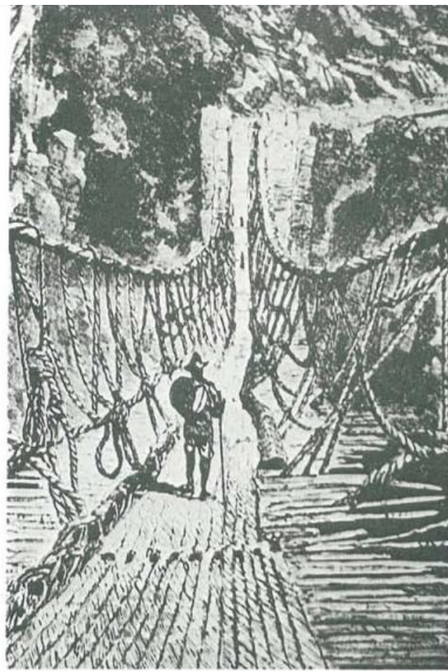
Antigua pasarela colgada de cuerdas. Constituye un antecesor notable de las recientes pasarelas en banda tensada.
