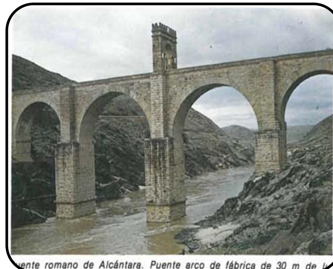
ente romano de Alcántara. Puente arco de fábrica de 30 m de l
