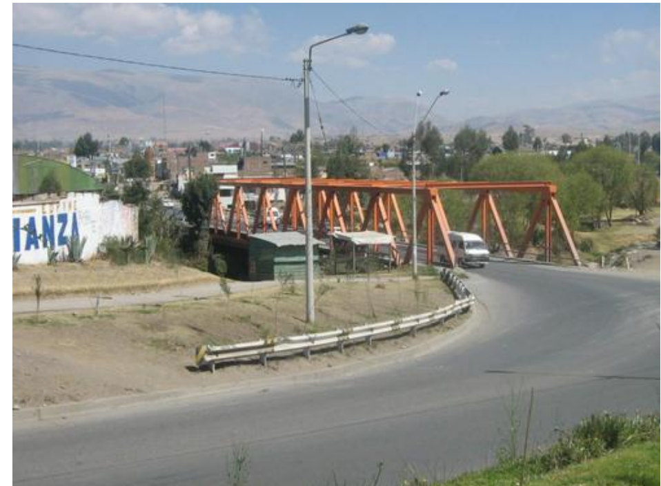
Puente La Breña – Huancayo, se construyó en la década 70 y longitud de 60.00 m
